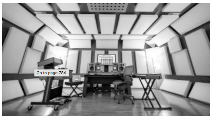
Hình 21.17: Bẫy bass hoạt động tốt ở góc tường và trần nhà, cũng như ở góc, chỗ hai bức tường gặp nhau. Lưu ý bẫy bass hình tam giác gần trần nhà phía trên bẫy phẳng đặt trên góc tường để xử lý những góc ba cạnh quan trọng.
