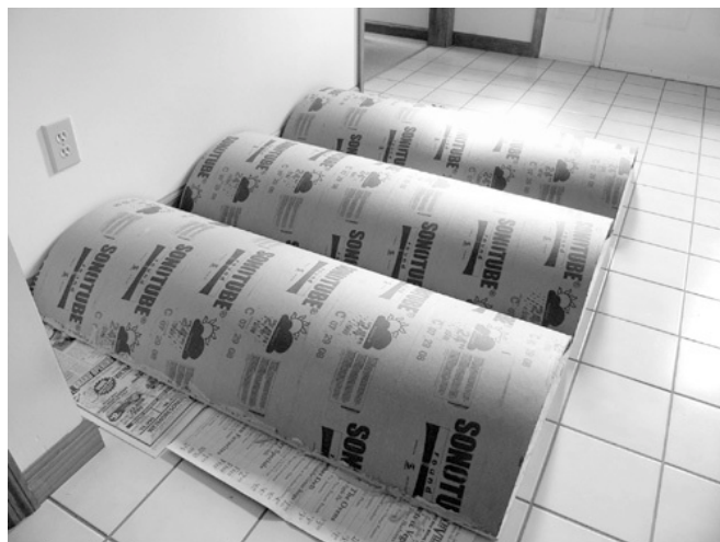
Hình 21.12: Những bộ làm lệch poly này chế tạo từ tấm carton, có đường kính 24 inch.
