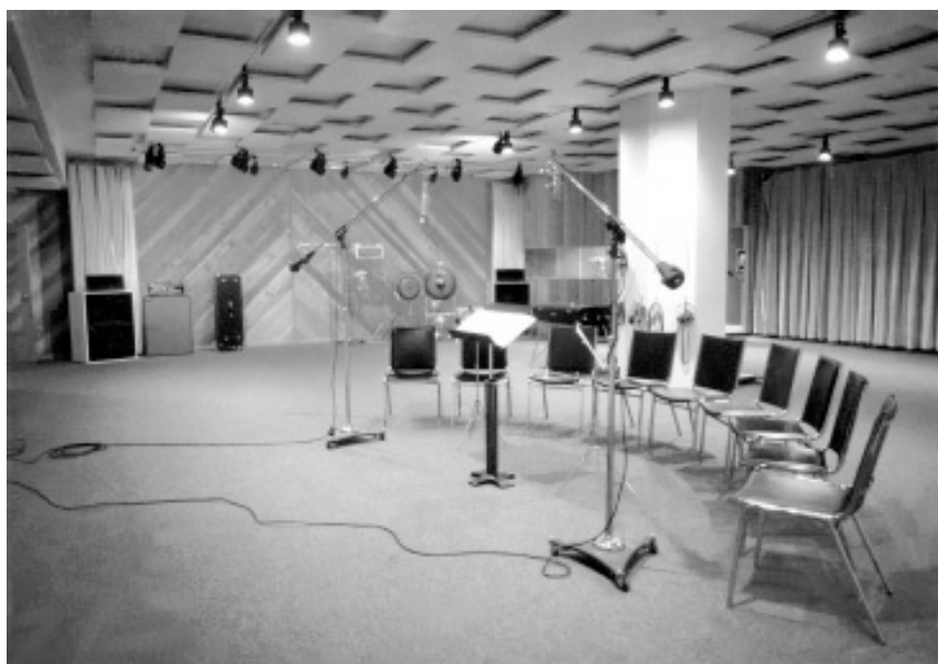
Hình 21.23: Phòng sống lớn này có màn sân khấu xếp nếp rất dày che phủ hai bức tường, cho phép thay đổi thời gian reverb rất lớn khi cả hai màn mở hay kéo vào hoàn toàn.
